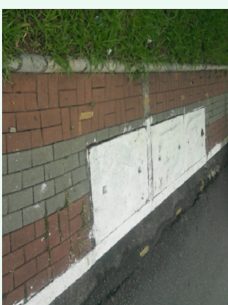
7) Reforma e padronização de Calçadas
